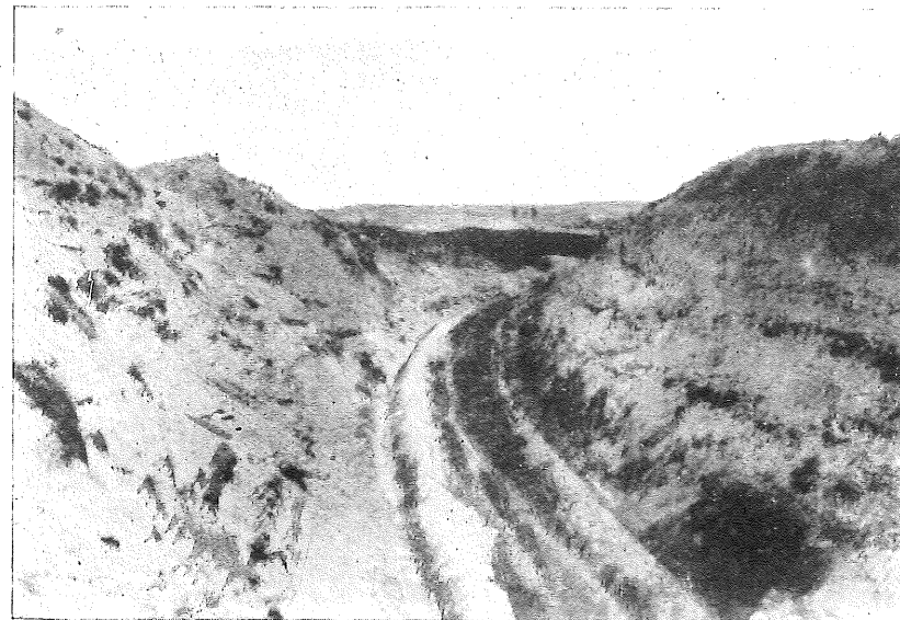
Fig. 7.—Trinchera del ferrocarril Madrid-Burgos, a unos 100 metros al Norte de la estación de Gumiel de Izán, en el tramo de las arenas y areniscas tiernas tortonienses, con estratificación cruzada.
